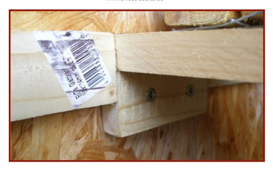
Der Außenbereich hat eine Größe von etwa 10 m² und besteht aus Rahmenelementen aus Volierendraht, die je nach Lage zueinander mittels Flachverbindern oder Winkeln an einander befestigt sind.
