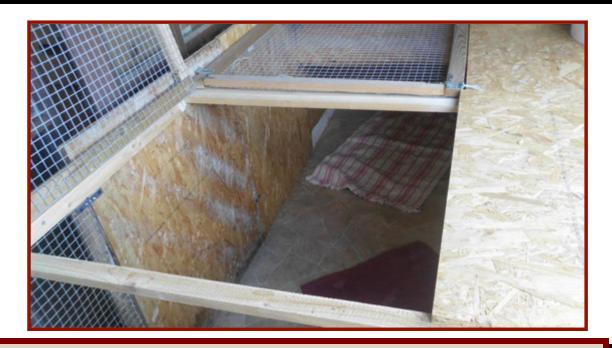
Diese Elemente liegen auf einer an den Rand geschraubten Holzleiste auf und sind dort sowie untereinander mit Überfallen gesichert. Die Querleisten, auf denen sie aufliegen, sind nur eingehängt, so dass sie auch zur leichten Reinigung vollständig entfernt werden können.
