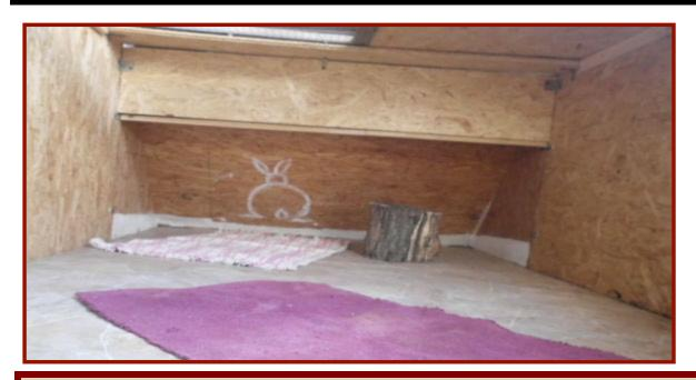
Die Seitenwände haben eine Höhe von 70 cm und bestehen im hinteren Teil aus 22mm starken OSB-Platten, die auf der Außenseite mit einem Schutzanstrich versehen wurden, so dass dieser Bereich vor Wind und Wetter geschützt ist und im vorderen Bereich aus Volierendraht, der mit Krampen auf einen Rahmen aus kesseldruckimprägnierten Latten gespannt ist.
