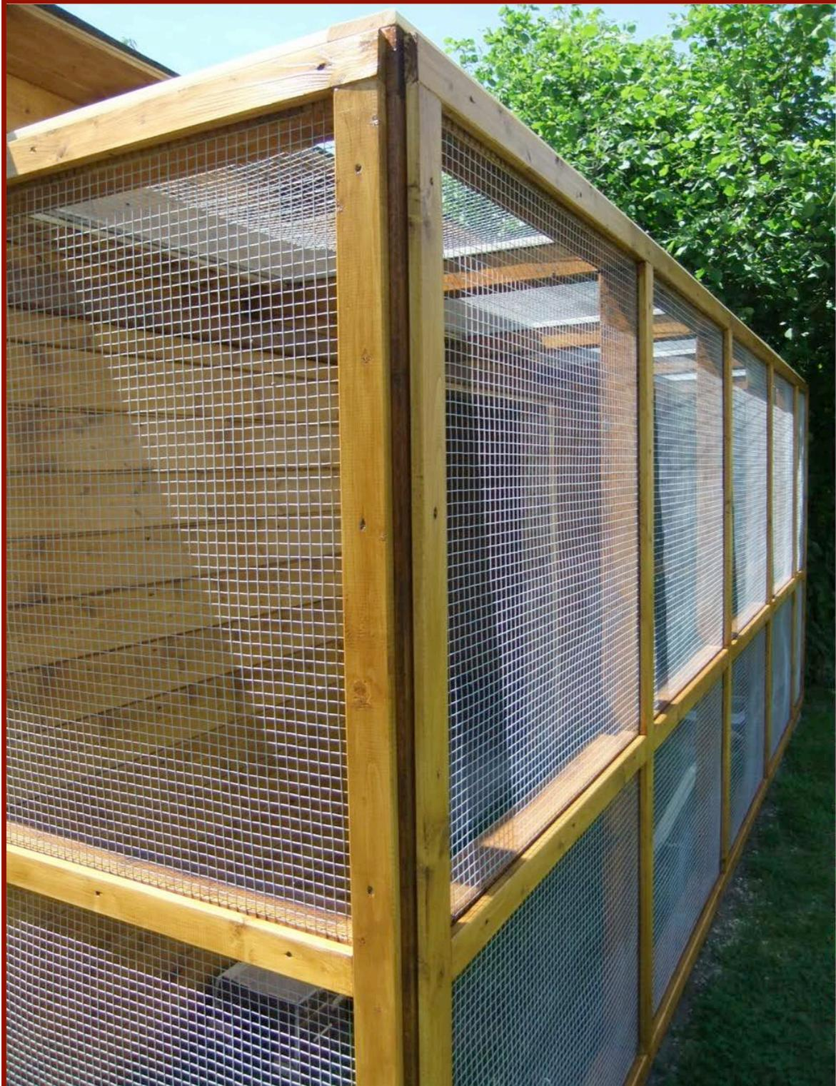
Der Außen- und Innenbereich ist verbunden mit einem 1,50 breiten und 1,80 hohen Durchgang. Da es im Winter aufgrund dessen doch sehr kalt im Innenbereich werden kann haben wir hierfür zwei Türen mithilfe von Scharnieren angebracht. Diese können im Sommer ganz schnell ausgehängt werden und bieten einen guten Schutz gegen Regen, Schnee und Kälte.
