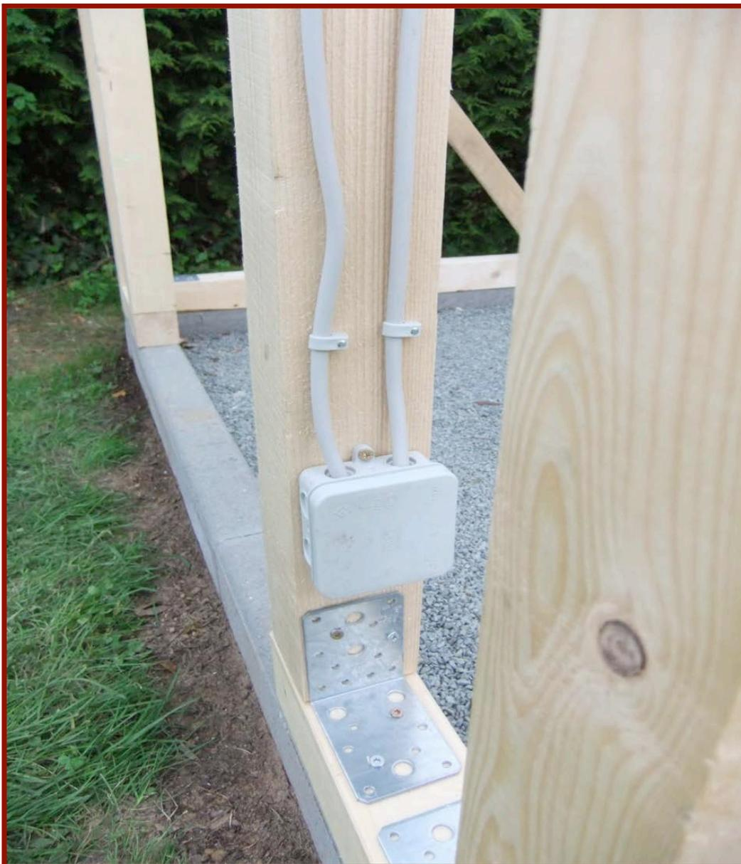
Im nächsten Schritt haben wir im vorderen Bereich noch Querbalken eingezogen um den Volierendraht besser befestigen zu können außerdem gibt das dem ganzen Gerüst etwas mehr Stabilität. Ebenfalls wurde die Eingangstür eingebaut.
