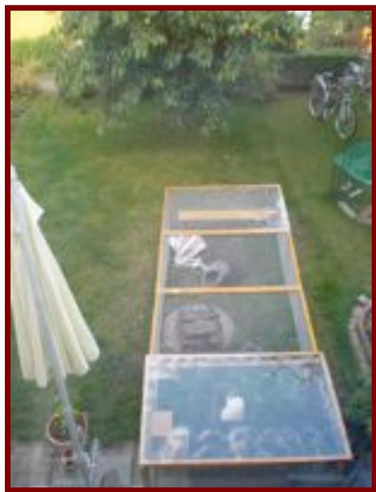
Der Anfang des Geheges wurde auf der Terrasse gemacht. Das Grundgerüst aus vorher lasiertem Holz wurde gebaut und anschließend mit Volierendraht (1,2mm Dicke, 16mm Maschenweite) bespannt.
