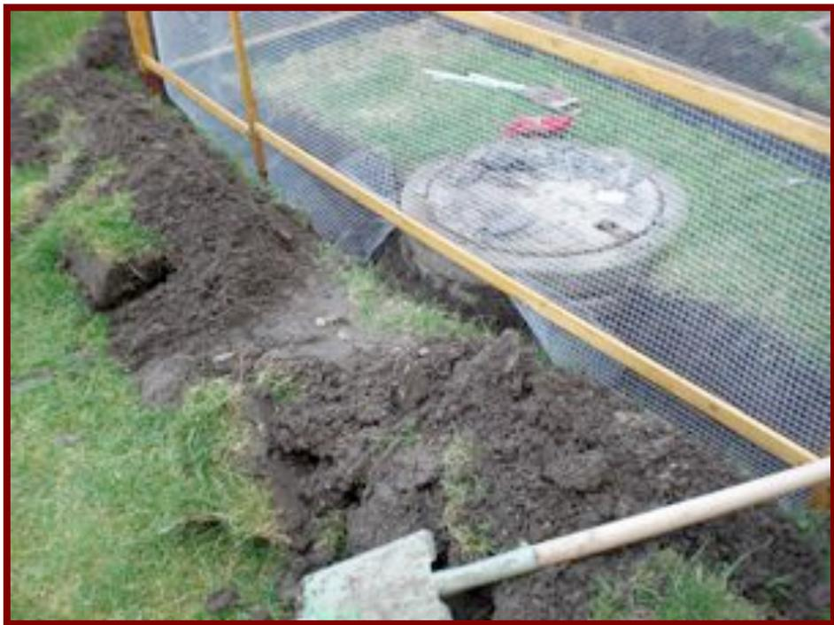
In 25cm Tiefe wurde der Volierendraht verlegt und mit dem Draht der Seitenwände mit Hilfe von Durchfädeln eines einzelnen Drahtes verbunden. Danach wurde die Erde wieder eingesetzt, bis auf ein Loch von ca. 60x40cm, welches später mit Sand zum Buddeln befüllt wurde.
