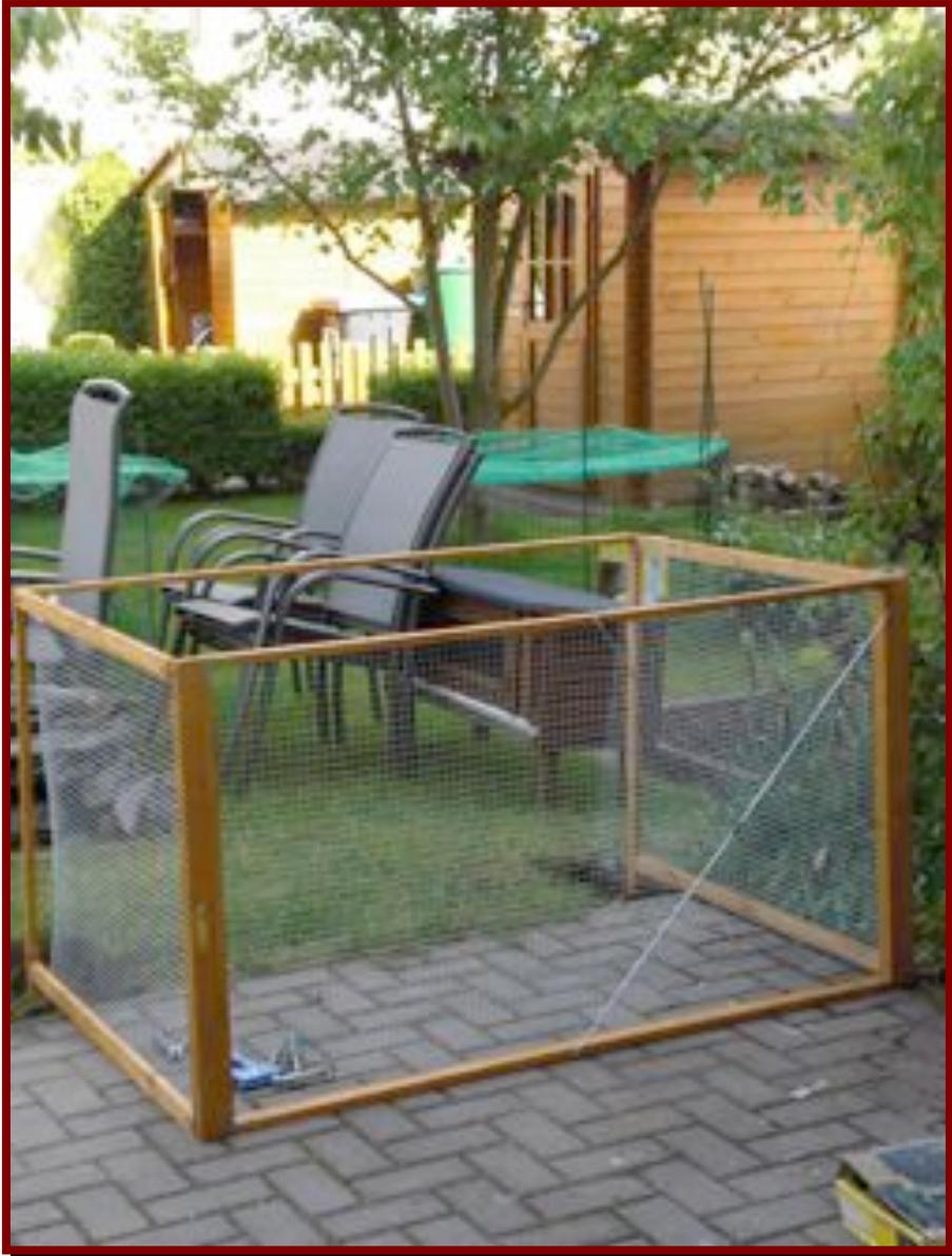
Anschließend wurde das restliche Gerüst mit Winkeln zusammenschraubt. Erste Rasenstücke mussten u.a. für die Versenkung der Holzleisten ausgehoben werden. Von innen wurde wieder Volierendraht festgetackert. Der Deckel der Wasserzisterne ist im Gehege integriert, da es letztendlich aufwendiger gewesen wäre, ihn durch Drumherumbauen außen vor zu lassen.
