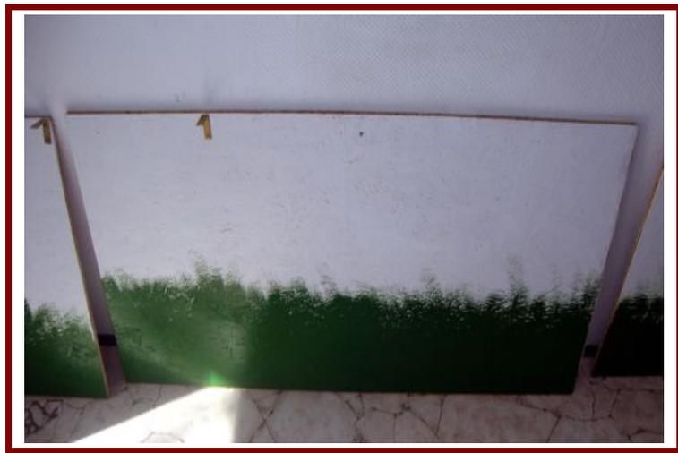
Diese Platten wurden mit Schrauben an der Wand befestigt um ein unkontrolliertes Umfallen zu verhindern und der oberen Konstruktion, die nachfolgend beschrieben wird, einen Halt zu bieten.
