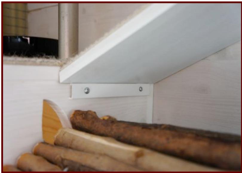
Befestigt haben wir das Penthouse relativ unsichtbar mit Regalbodenhaltern an der Wand, der untere Teil der Halter wird vom Knabber- und Kabelschutz verdeckt:
