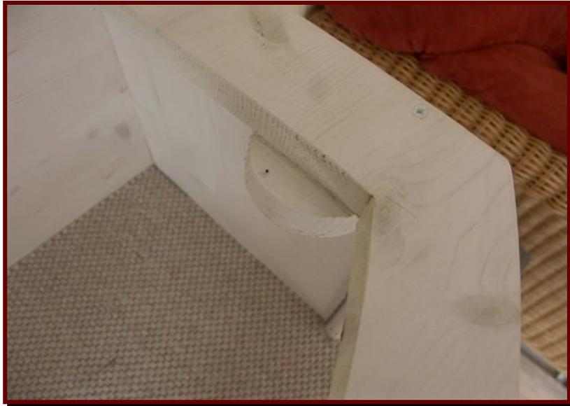
Den vorderen Teil des Penthouses haben wir mit Rundhölzern stabilisiert, die jeweils durch den Boden und der Decke durch Schrauben befestigt wurden:
