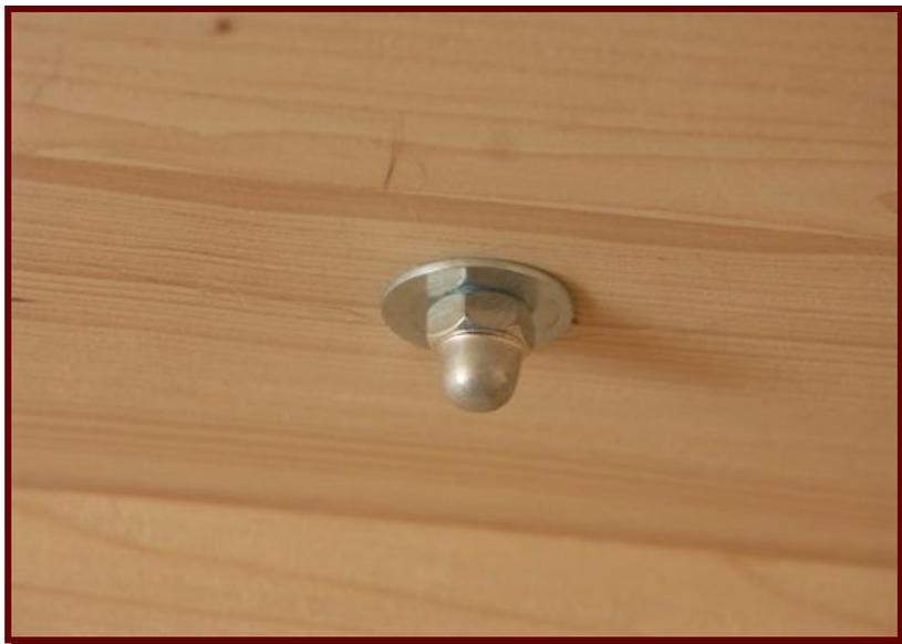
Die andere Seite der Gewindestange wurde mit der Abdeckung am Fuß der Stütze verschraubt. Das Dach der Loggia wurde dann wieder mit Schrauben an den vorgesehen Bohrungen der Stützen verschraubt:
